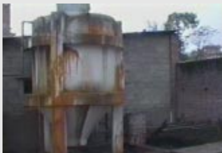
中央左に見えるタンクが廃液処理施設の一つ。 ここで、固形化して、次の施設で焼却する。
